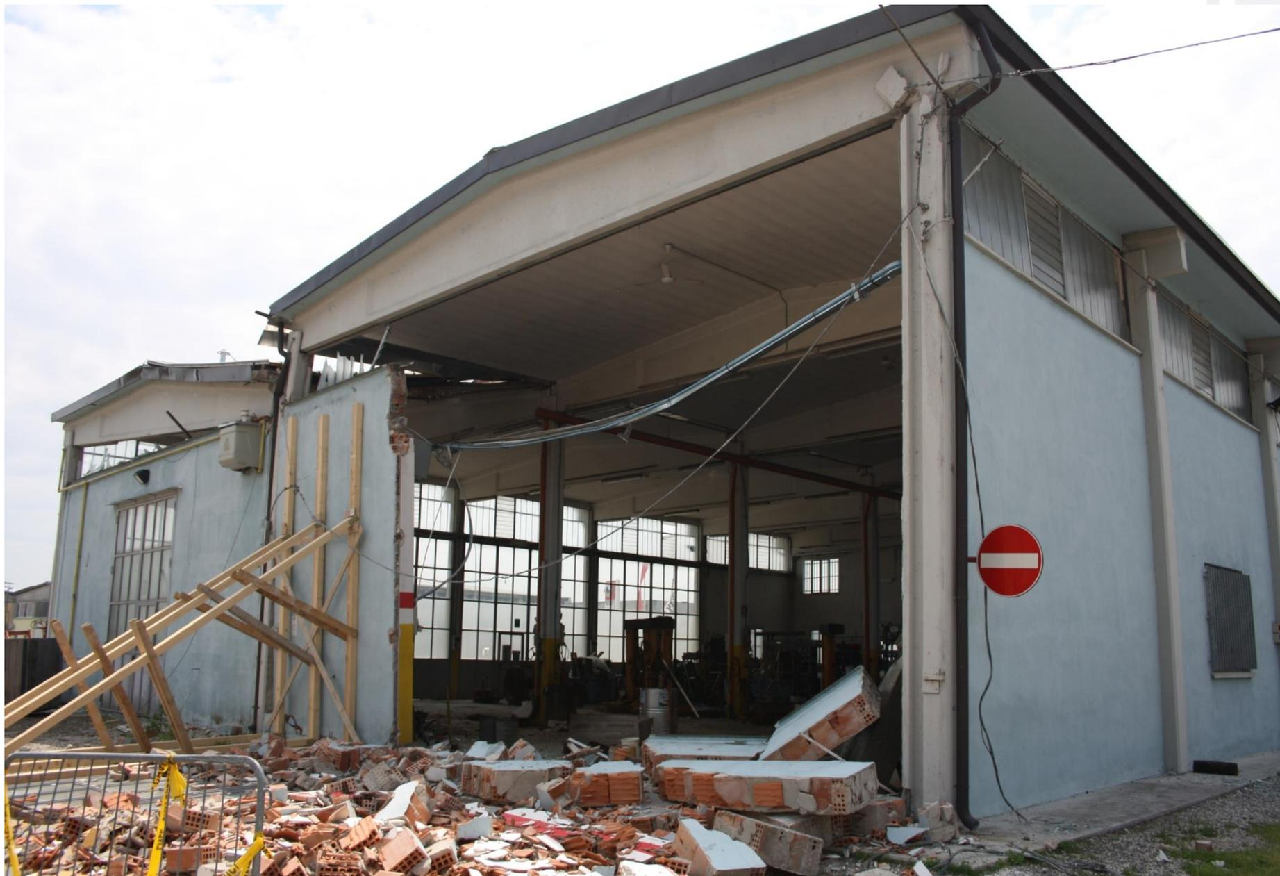
**Figura 2** ➤ Perdita di appoggio della trave principale a sezione variabile in un edificio monopiano prefabbricato con trave principale trasversale di non recente costruzione a causa della crisi a taglio del pilastro di appoggio, reso tozzo dalla configurazione del pannello di tamponatura
