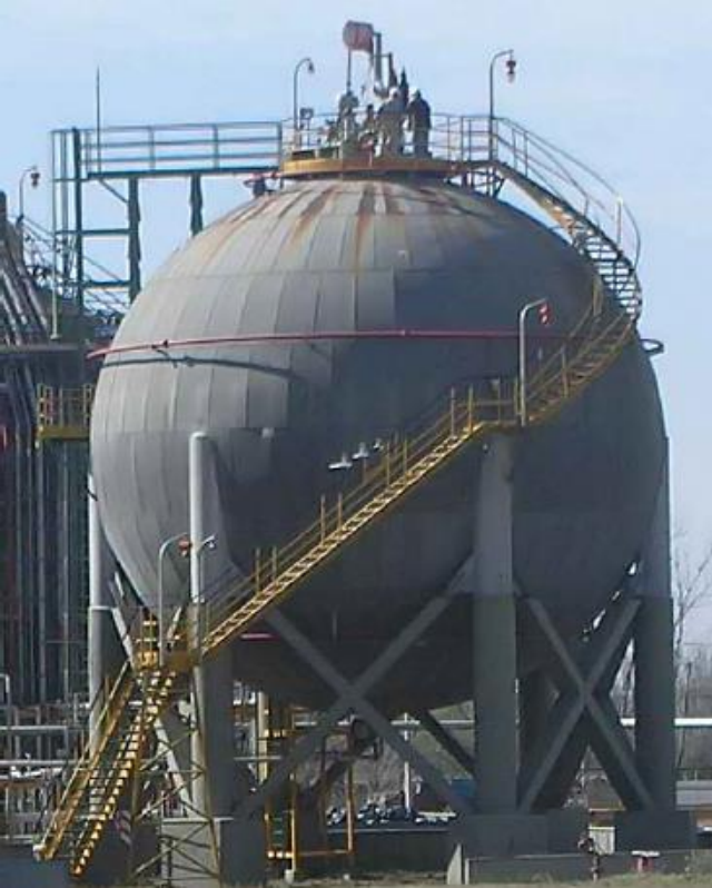
Controventamento dissipativo
