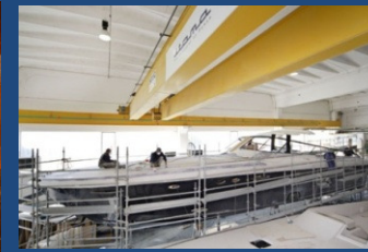
ATTREZZATURE DI MOVIMENTAZIONE
